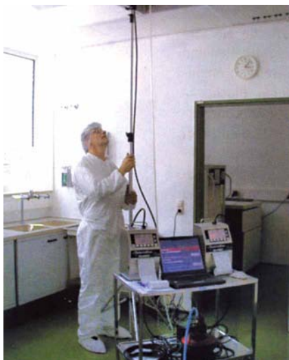
Проверка фильтра на наличие утечек с одновременным измерением содержания частиц в неочищенном воздухе
